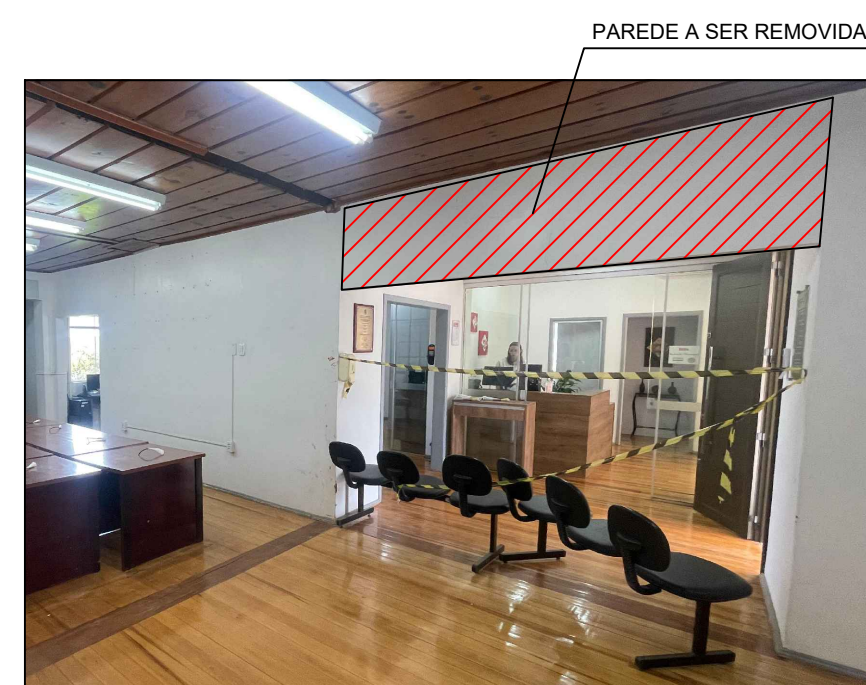
IMAGEM 01 (PAREDE A SER DEMOLIDA)
